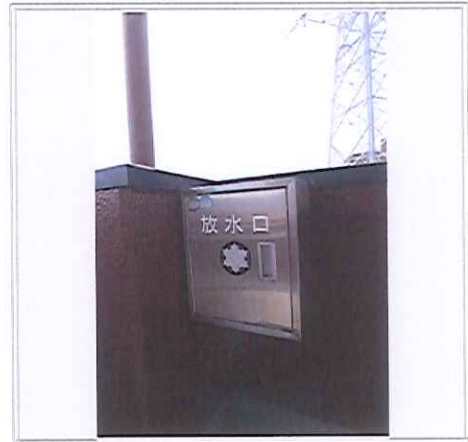
階段横放水口
