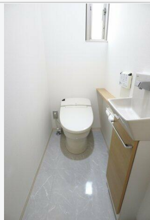
タンクレストイレは温水洗浄便座機能付！
