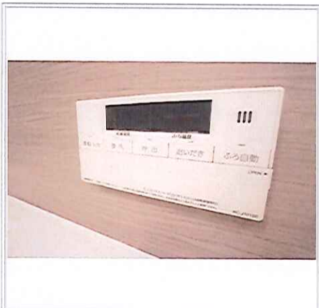
バスルーム 給湯器操作リモコン
