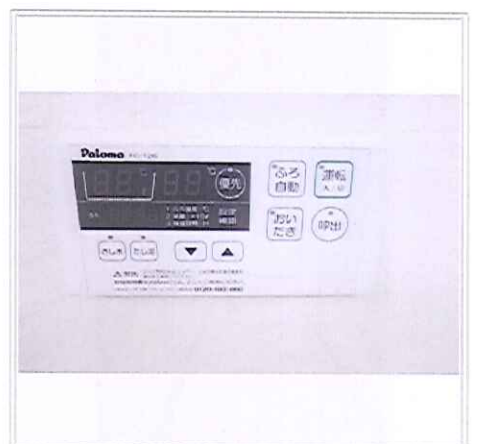
給湯システムの操作パネル
