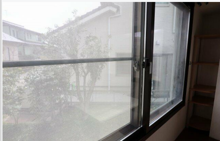
1階LDKは2重サッシ施工済み
