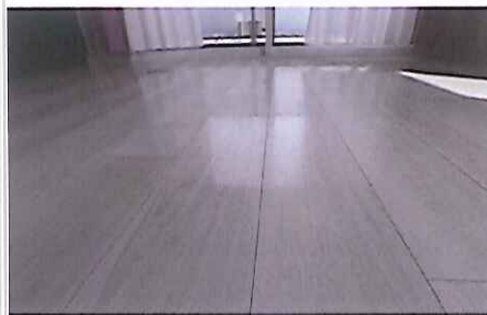
全室フローリングには傷防止、防汚効果のコーティング施工を実施
