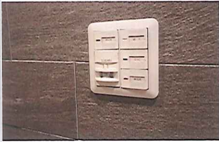
玄関の壁はタイル張り 人感センサー付きライト
