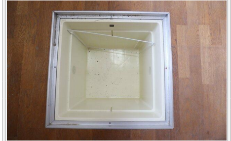
床下点検口兼収納
