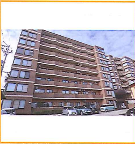
2022年大規模修繕が完了し、とても綺麗な外観です！富山駅や小学校、中学校へのアクセス、交通の便もとて
