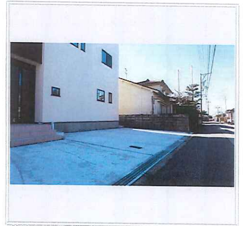
敷地内3台駐車可能
