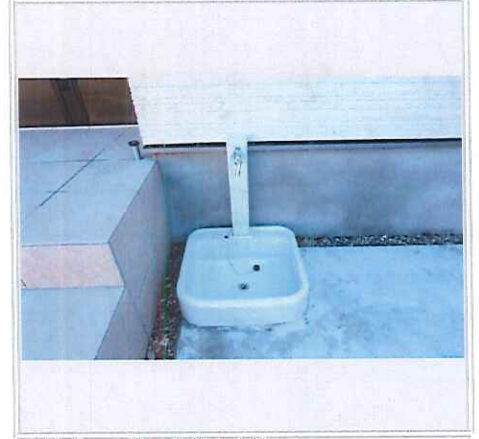
玄関ポーチ横に外部立水栓
