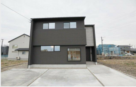
カナディアンホーム施工のスタイリッシュな外観
