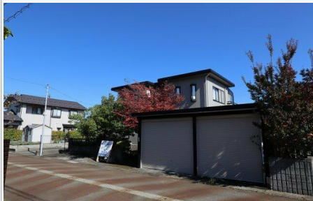
鉄骨造の重厚感ある外観♪2台分の車庫付き！
