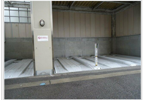
機械式駐車場
