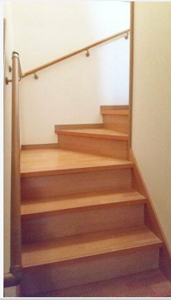
手すり付き階段
