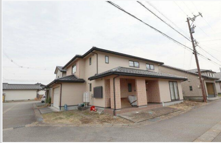
リブハウス施工の2×4工法のお家♪
