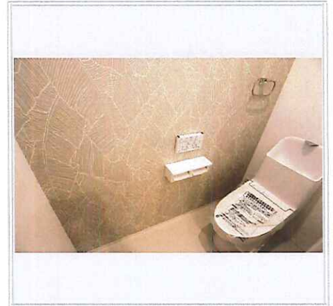
2階 温水洗浄便座 収納箇所もしっかり設置されています☆
