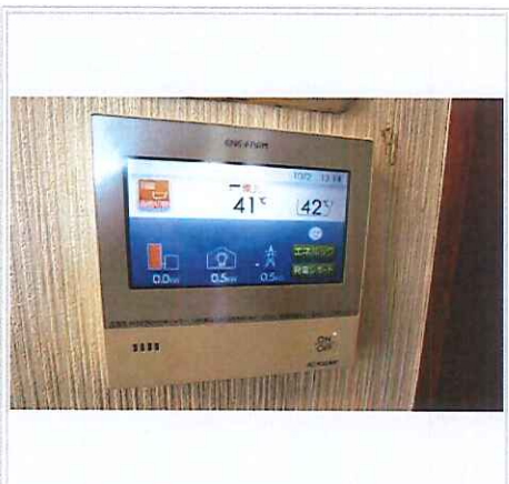
エネファーム 発電状況を確認できるパネルです！
