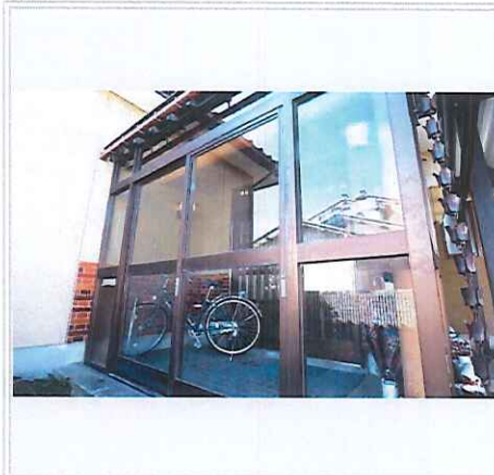
風除室 玄関の前に、風除け・雪の吹きだまり対策バッチリ☆
