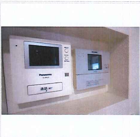
モニターホン付きインターホン、給湯器コントロールパネル
