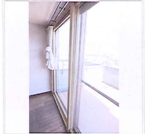
LDKの二重サッシ 各部屋の窓は二重サッシにリフォームされており、断熱性に優れています
