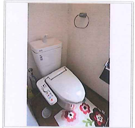
2F 温水便座付トイレ
