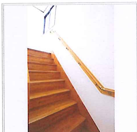
3階から4階への階段 手すり付きで安心♪
