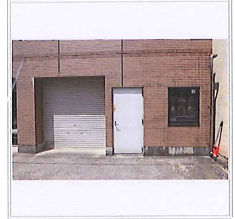
1Fには店舗用スペースがあります
