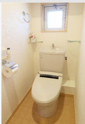
自動洗浄機付トイレ
