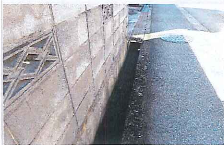
北側道路側の側溝
