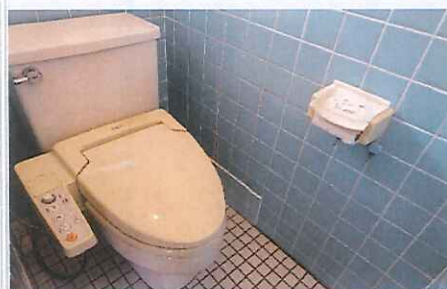
温水洗浄便座 床は水洗いしやすいタイル張り♪
