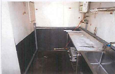
テナント部分厨房！
