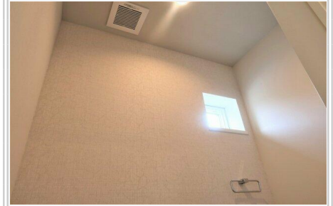
2階トイレの換気扇と窓
