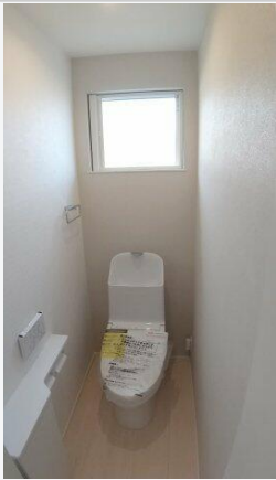
2階手洗い場付トイレ (自動洗浄機付)
