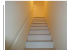
安心・安全の手すり付き階段
